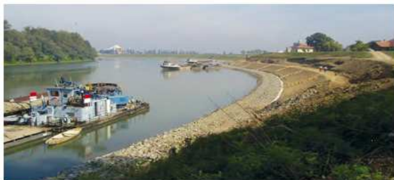
Slika: Kosa obaloutvrda s oblogom od lomljenog kamena
