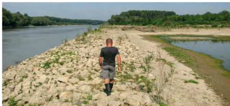
Slika: Paralelna regulacijska građevina na rijeci Savi – „Račanski sektor“
