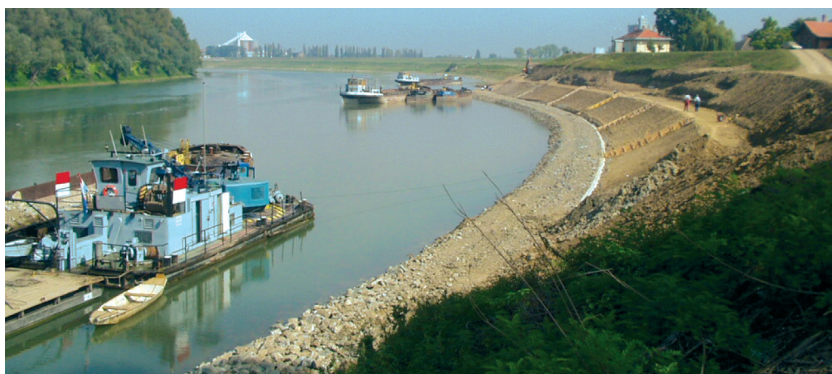
Slika 4. Kosa obaloutvrda s oblogom od lomljenog kamena
