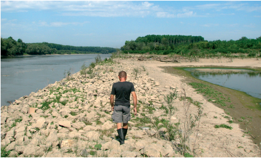
Slika 5. Prava paralelna građevina na rijeci Savi
