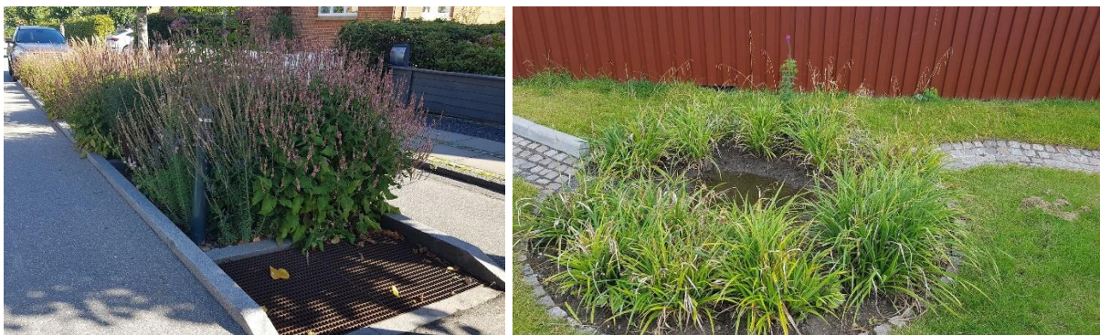
Слике 2: Кишни врт за задржавање и прочишћавање оброринских вода са улице, паркиралишта или кровова: вода се прочишћава филтрацијом кроз супстрат, дјеловањем микроба и упијањем од стране биљака. Кишни вртови такође су прекрасан естетски
