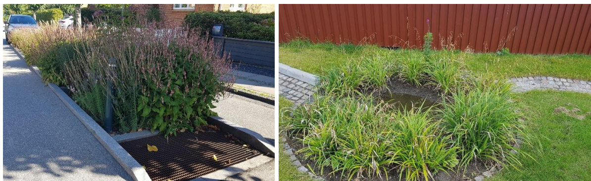
Slika 2: Kišni vrt za zadržavanje i pročišćavanje oborinskih voda s ulice, parkirališta ili krovova: voda se pročišćava filtracijom kroz supstrat, djelovanjem mikroba i upijanjem od
