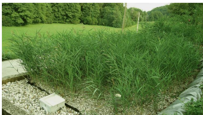
Slike 4: Biljni uređaji za pročišćavanje otpadnih voda prirodno su, efikasno i robusno rješenje za pročišćavanje otpadnih voda iz individualnih kuća i naselja. (Foto i shema: LIMNOS d.o.o.)
