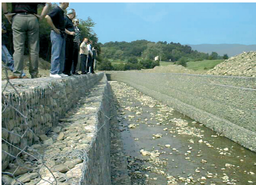
Slika 3. Vertikalna gravitacijska obaloutvrda od gabionskih košara
