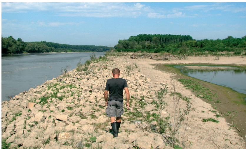
Slika 5. Prava paralelna građevina na rijeci Savi
