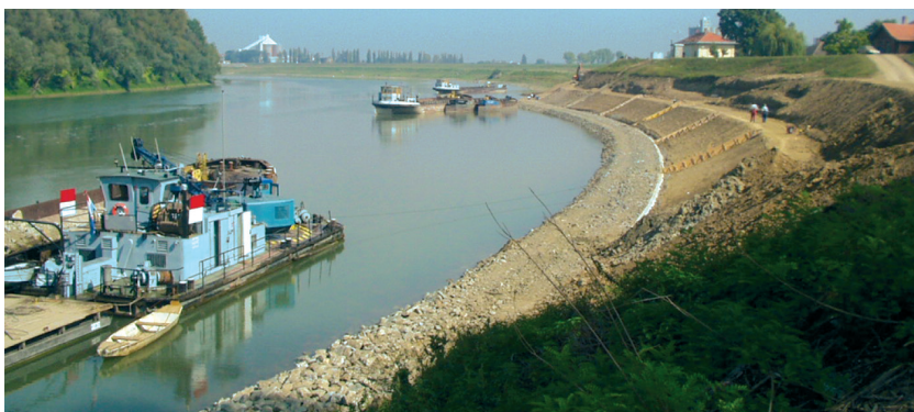
Slika 4. Kosa obaloutvrda s oblogom od lomljenog kamena
