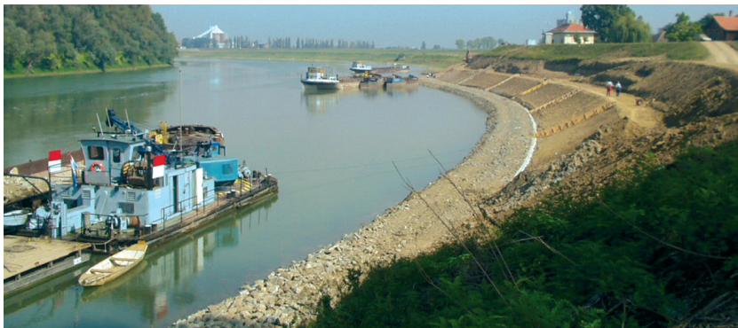
Слика 4. Коса обалоутврда са облогом од ломљеног камена
