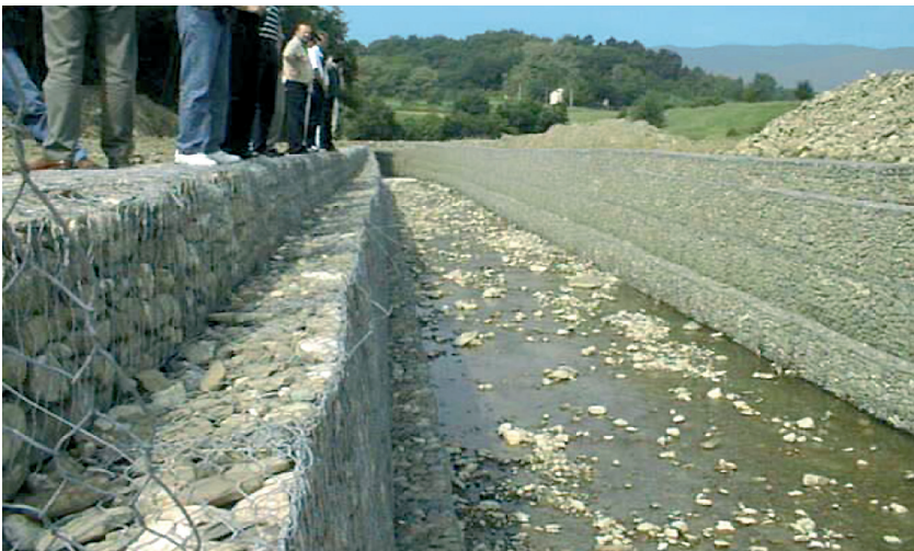
Слика 3. Вертикална гравитациона обалоутврда од габионских кошара
